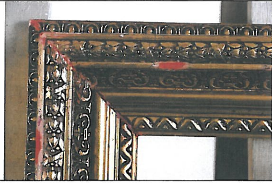
Hiányok tömítése és kittelése.
